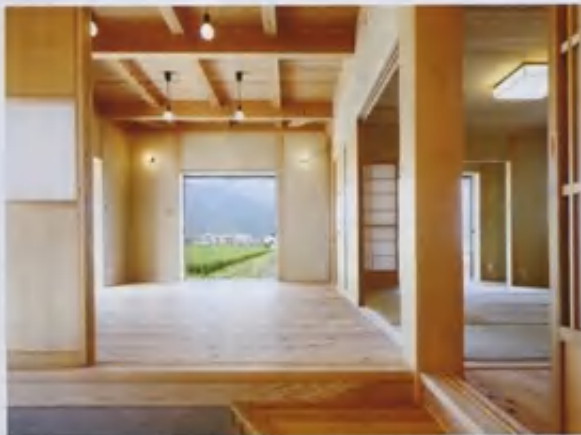
大黒柱を中心に、昔ながらの田の字構造の1階部分。
