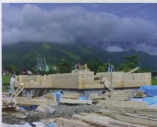
組み立て作業の現場。県内外に仕事先は広がっている。
